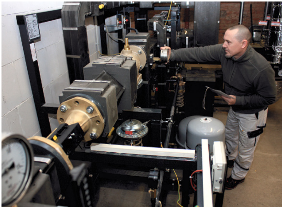
Mitarbeiter Andreas Schulz-Oertel im Keller von Haus 5 der Wohnstätte Altendorf bei der Installation der umfassenden Regeltechnik. Foto: see
