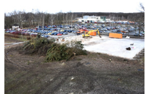
Nach zwei Wochen ist von den Hallen bis auf die Bodenplatten nichts mehr übrig – hier ein Blick aus Haus D Richtung Nordosten. Foto: Merkel
