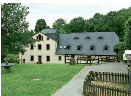
Die Wetzelmühle in Niederfrohna.
