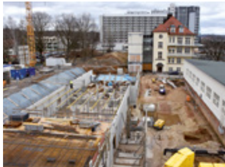
Der Neubau für das Eltern-Kind-Zentrum an der Flemingstraße 4 wächst bereits schnell in die Höhe.
