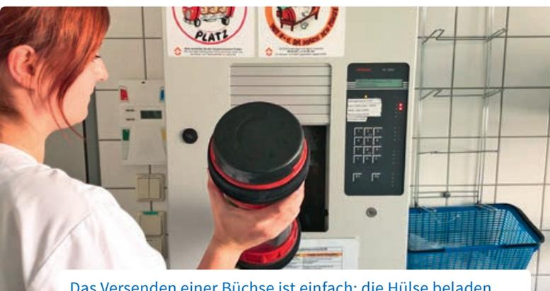
Das Versenden einer Büchse ist einfach: die Hülse beladen, in die Versandstation stellen und dann die Rohrpostnummer der gewünschten Station eingeben. Die Plastik-Kapseln sind 37 Zentimeter lang und mit 16 Zentimeter Breite nur etwas schmaler als das Transportsystem.
