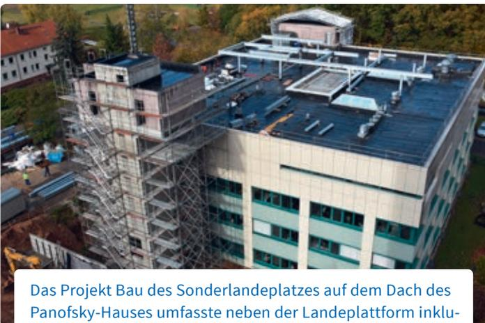
Das Projekt Bau des Sonderlandeplatzes auf dem Dach des Panofsky-Hauses umfasste neben der Landeplattform inklusive Technik die Errichtung eines Fahrstuhlschachts sowie eines Verbindungsgangs zur Zentralen Notaufnahme.
