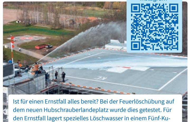
Ist für einen Ernstfall alles bereit? Bei der Feuerlöschübung auf dem neuen Hubschrauberlandeplatz wurde dies getestet. Für den Ernstfall lagert spezielles Löschwasser in einem Fünf-Kubikmeter-Tank unter der Plattform. Die beiden Wasserkanonen können 500 Liter Löschwasser pro Minute verspritzen.
